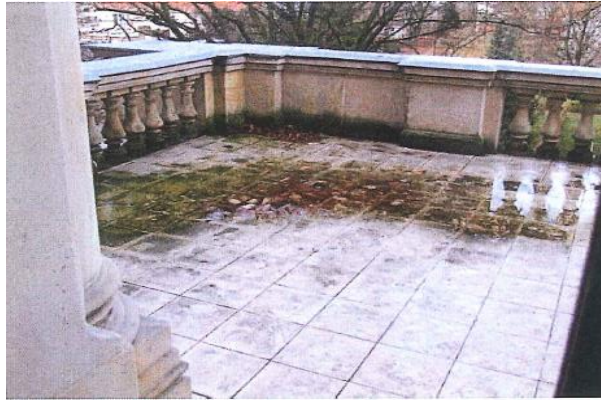
Рисунок 2.2.6 Неправильне відведення дощової води на терасі спричинило біологічну корозію
